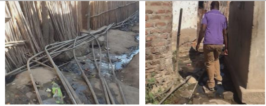
Figura 35 – Tubos de Água para Abastecimento e “Águas Negras” num Bairro Periférico
