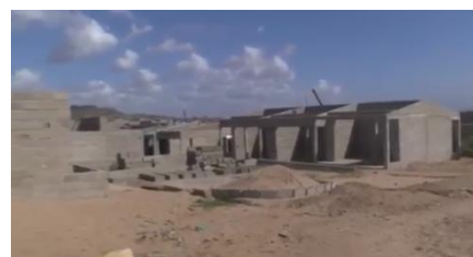
Figura 23 – Obras do Novo Mercado Kwachena
