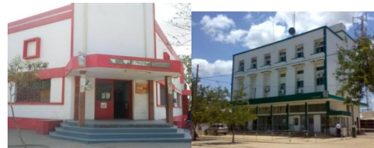
Figura 40 – Edifício dos Correios e Edifício da TDM
