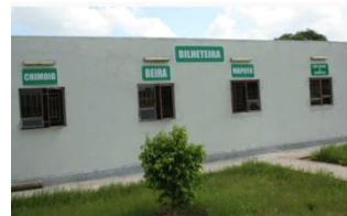
Figura 37 – Novo Terminal Rodoviário
